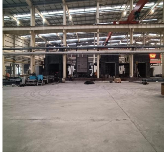
均质炉+冷却炉
