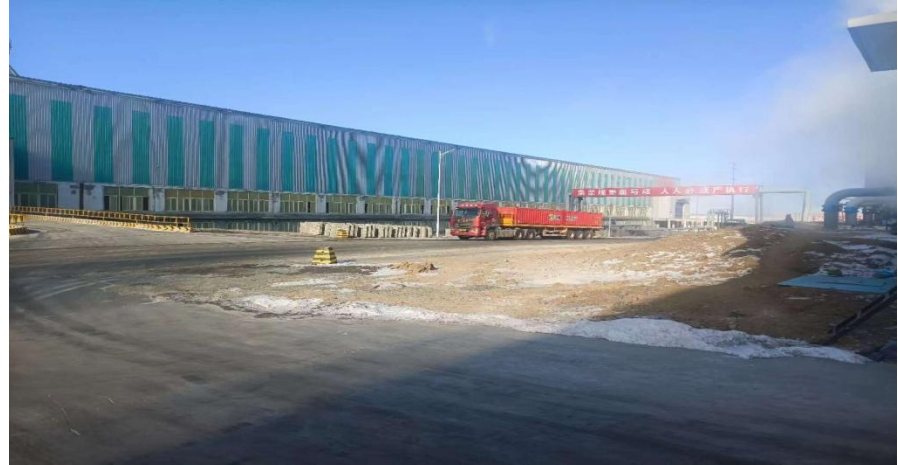
北侧电解厂房
